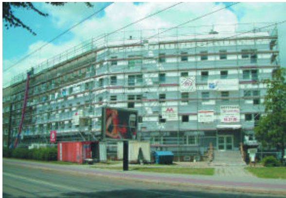
Neugestaltung der Fassade
