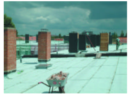
Neueindeckung des Dachbereiches
